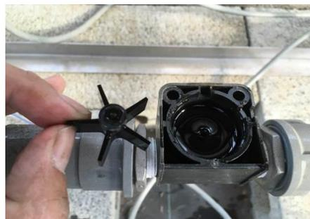
7 分解が終わりましたらケース内部を掃除、洗浄をし、逆の手順で組み立ててください。
