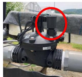
ドロット電磁弁のコイル
